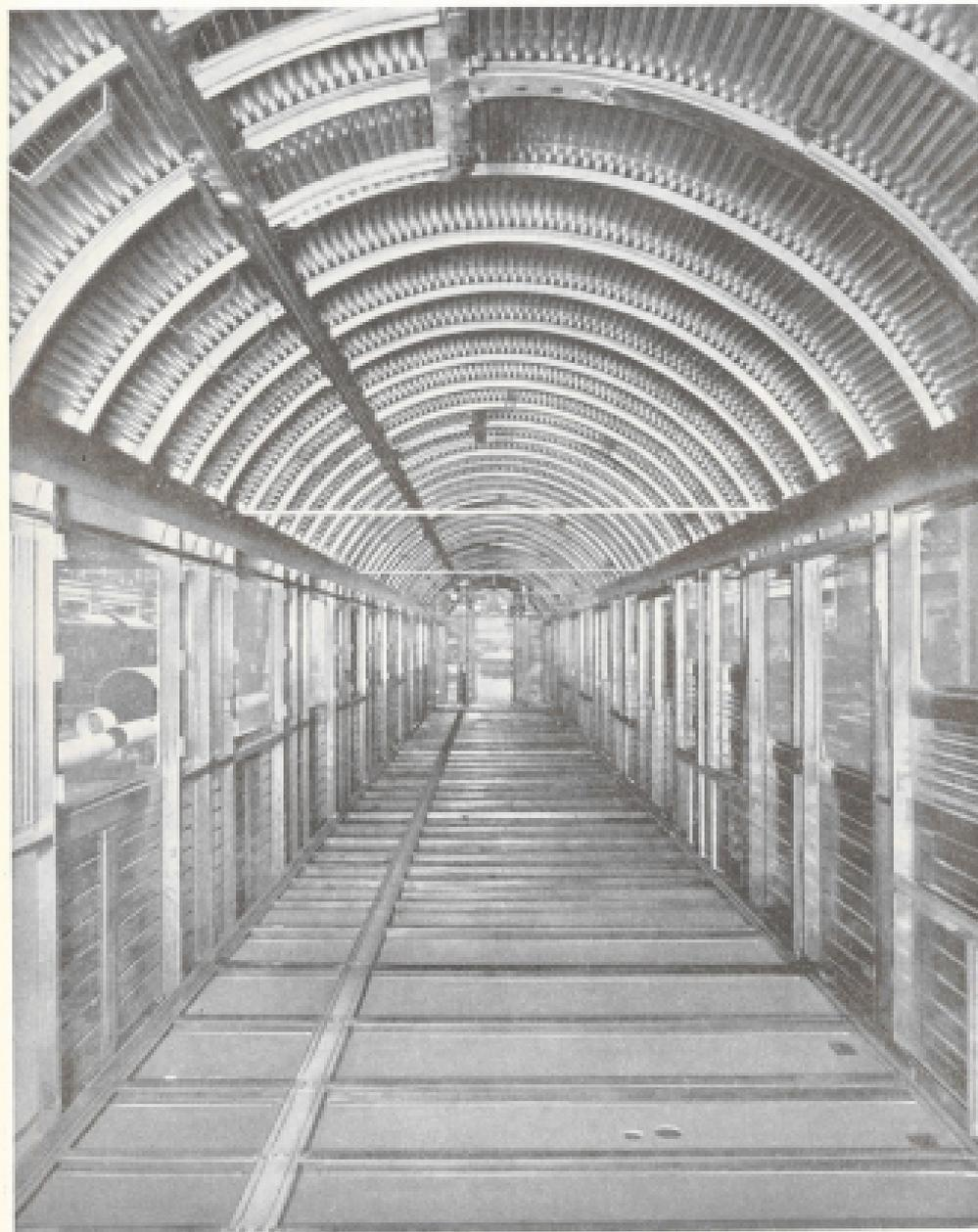
Interno di una delle vetture letto di 2a classe, in acciaio inossidabile, in costruzione al nostro Stabilimento Ferroviario.
